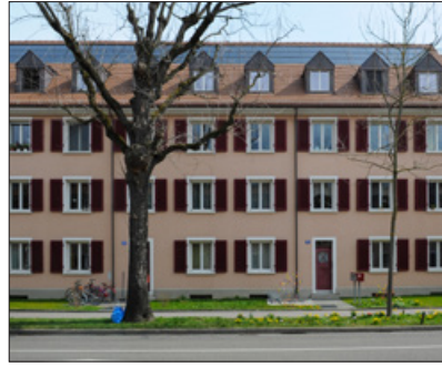
Klassische Reihenhäuser mit Schlagläden und Mansarden, WG Im Langen Loh.
